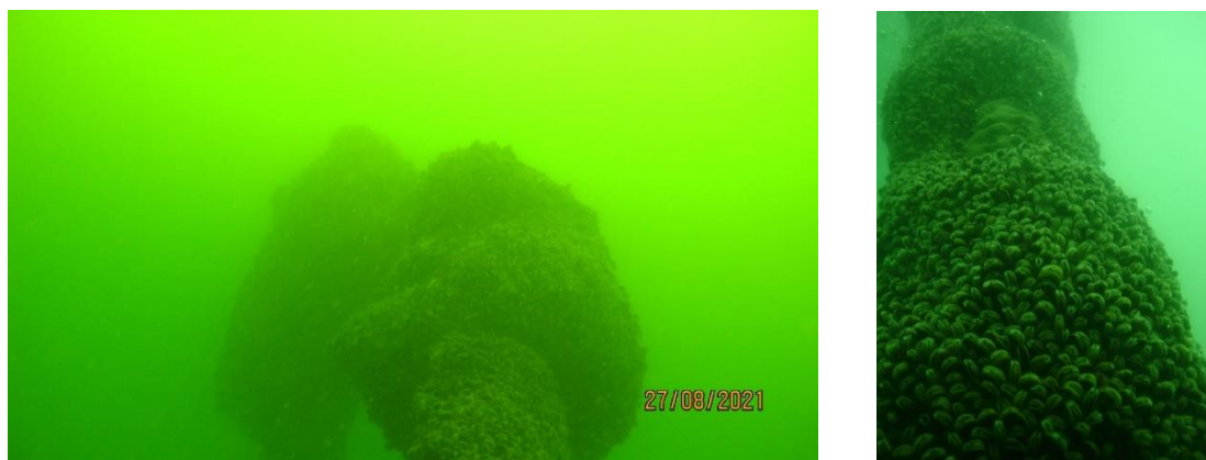
Figure 11 : colonisation du mouillage de la bouée MOLIT par les moules – 27/08/2021 Photo : RDT/LDCM - M. Repecaud
