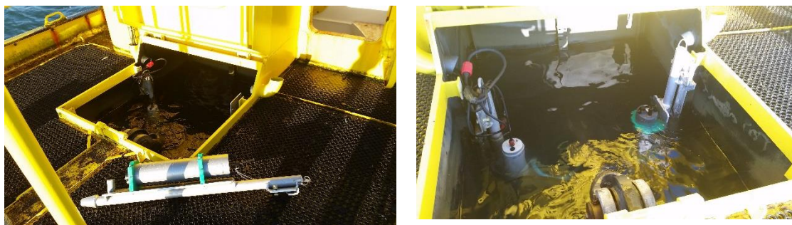
Figure 7 : Installation de la sonde SeaFET pH sur la bouée MOLIT.
