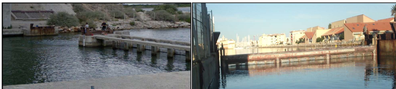
Figure 4 : (gauche) Structure béton et passe pouvant être fermée au moyen d'une porte amovible (en arrière-plan, sur le talus du pont, la porte en attente d'installation). (droite) Porte installée dans le grau de Port-Leucate (source des photos : Hydrriad Eau et Environnement).
