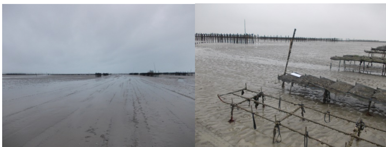
Figure 51 : A gauche, vue de la zone de dépôt à l'Ouest du Biez depuis le chemin conchylicole. A droite, zone de dépôt à l'Ouest du Biez, tables à huître au premier plan et structures béton au second –
