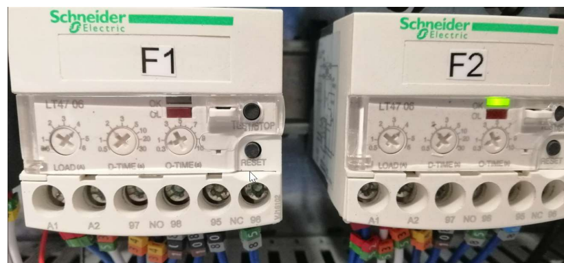
Fig.5 : Relais thermiques associés aux 2 broches
