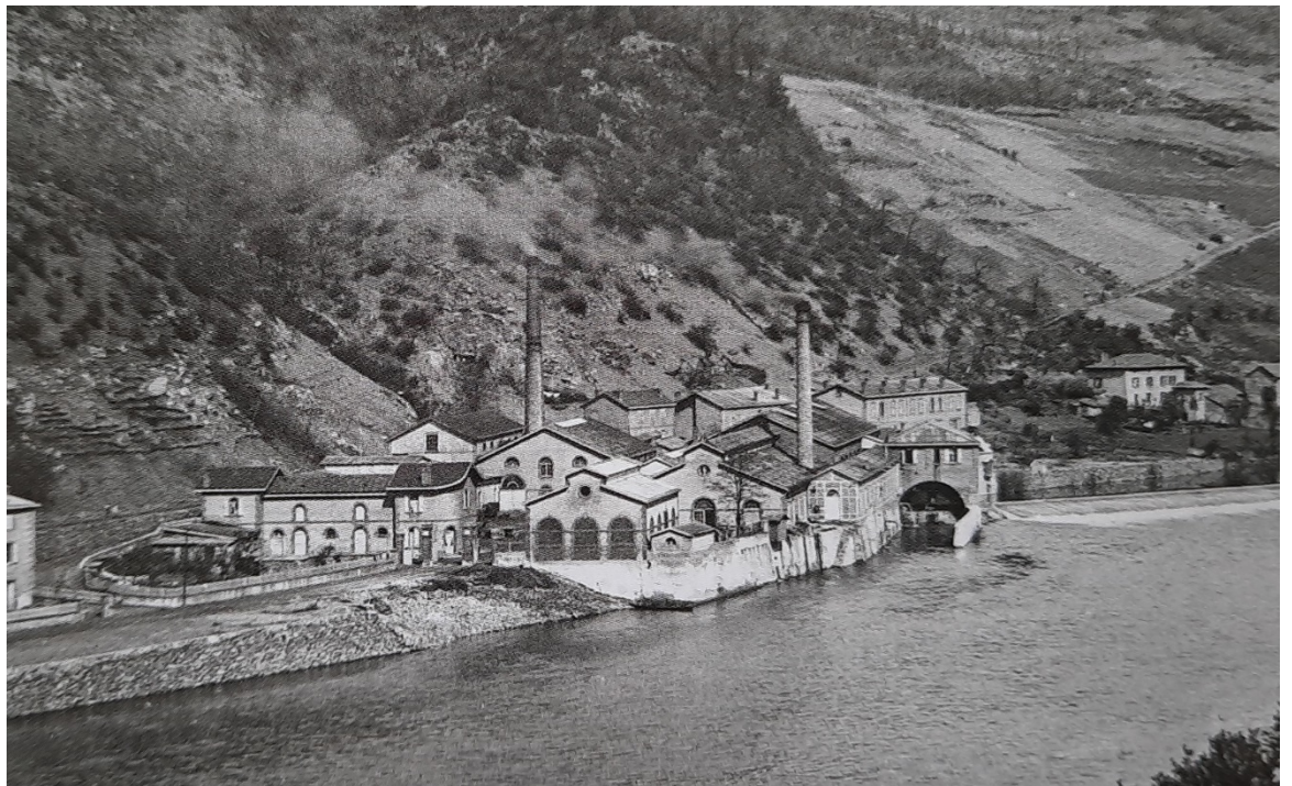
Fours à zinc, Viviez, usine de Vieille Montagne
