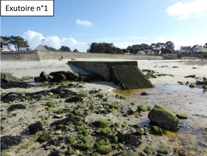
Canalisation – plage de Carnac
