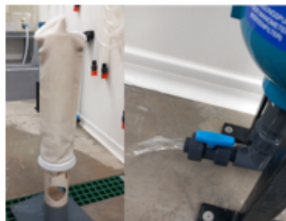
Figure 14 - Quelques étapes du nettoyage
