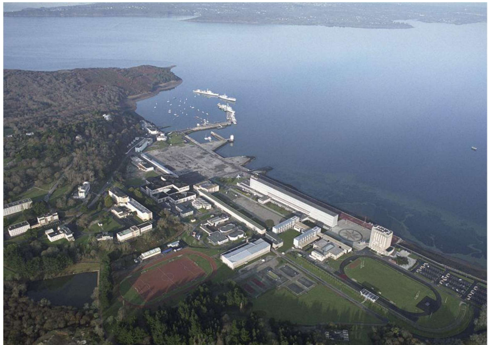
Cliché N°2 : Zone de l'Ecole Navale de Lanvéoc Poulmic
