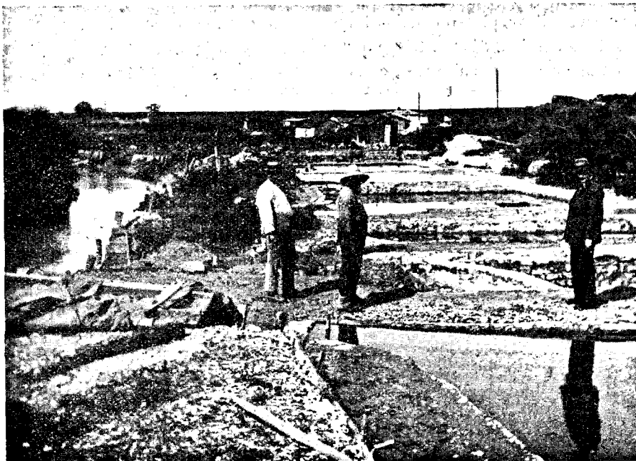
FIG. 3. — Mares en voie de transformation à LAUZIÈRES (Cl. L. Lambert)
