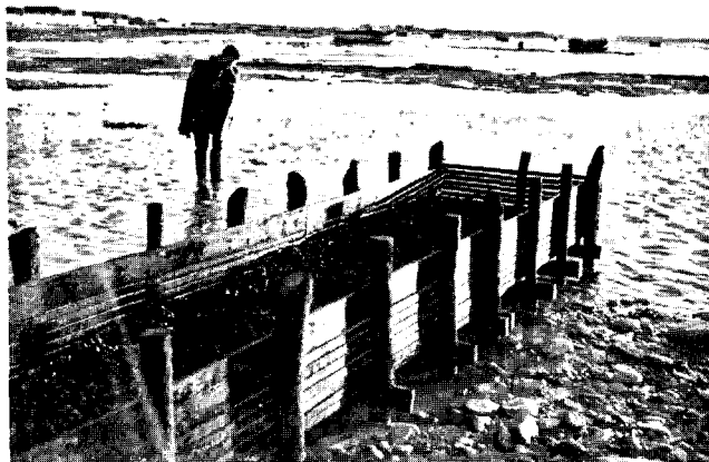
Fig. 2. — Cage dégorgeoir à la Jamble.
