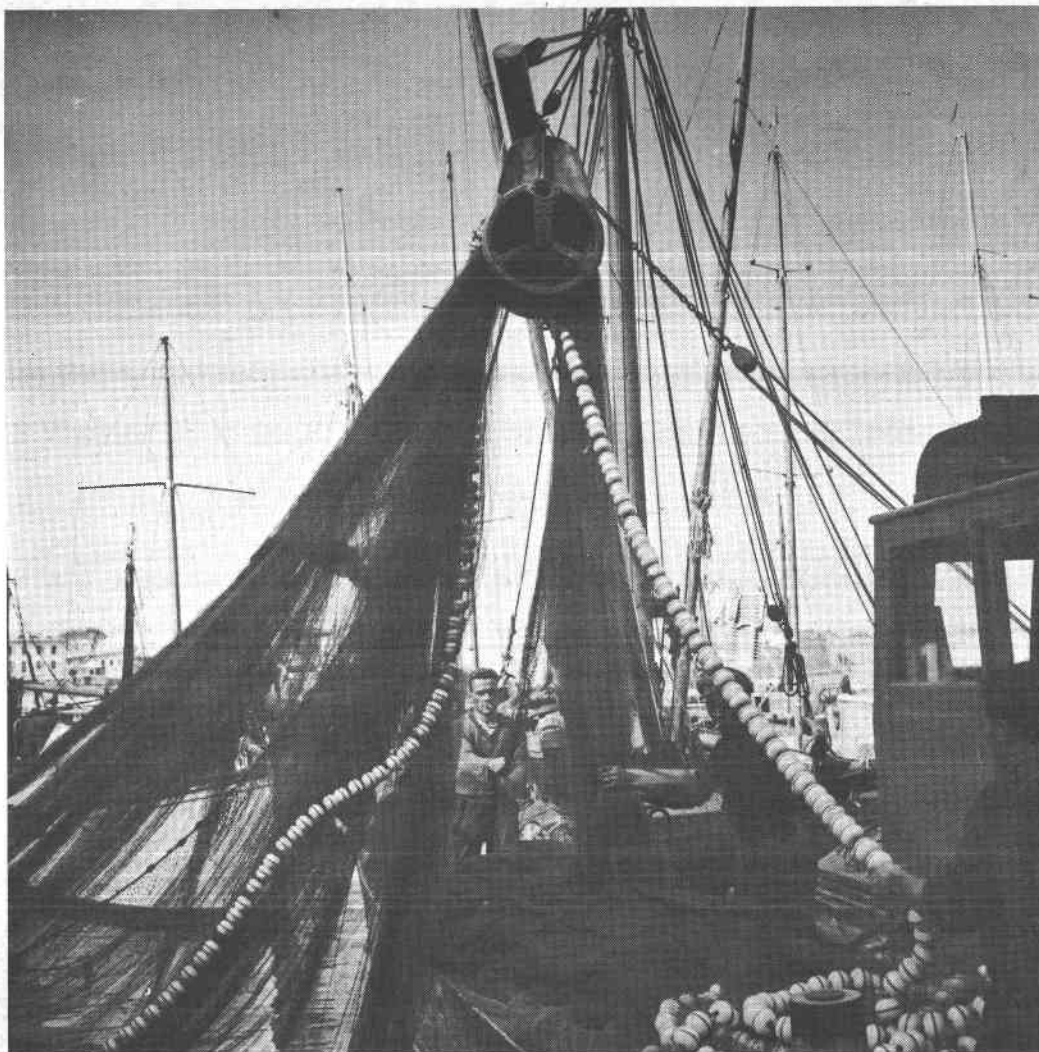
Fig. n° 5 - Le "Lutin" équipé de la poulie "power-block", au cours des démonstrations faites dans la région de Marseille en octobre 1961.
