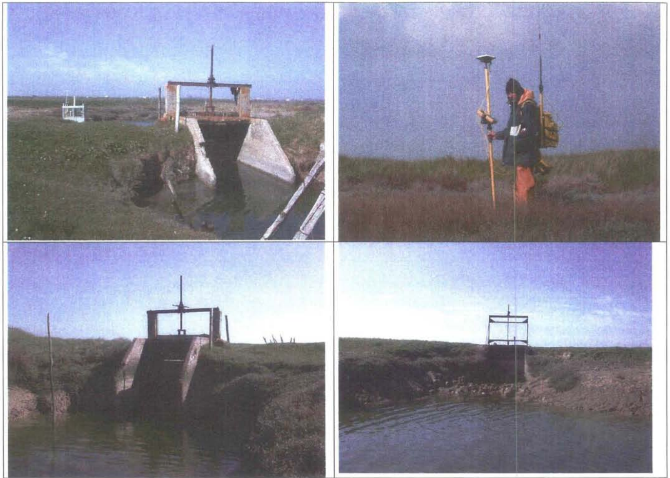
Figure 6 : Recensement et cotation des ouvrages hydrauliques de prise d'eau.
