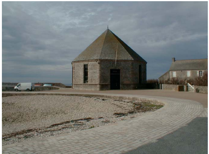
Station SNSM -Port de Goury
